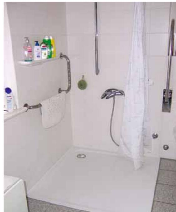
Eine bodengleiche Dusche sollte immer mit Haltegriffen ausgestattet werden.
