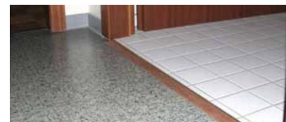
Niveauunterschiede können mit Schwellenkeilen ausgeglichen werden.
