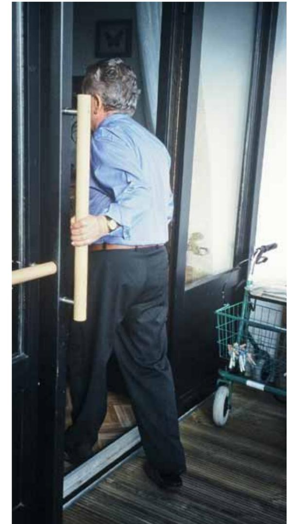
Die Stufe zum Balkon verschwindet durch das nachträgliche Anheben des Balkonfußbodens.
