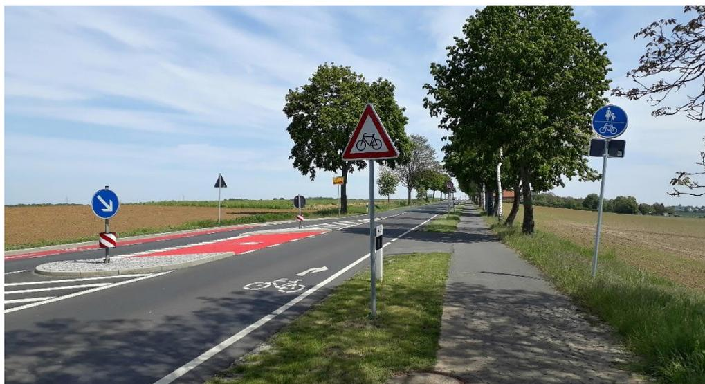
Abb. 22 Markierung von Fahrradpiktogrammen auf der Fahrbahn Übergang Fahrbahnführung innerorts und außerorts ben. RVA (Seelze)
