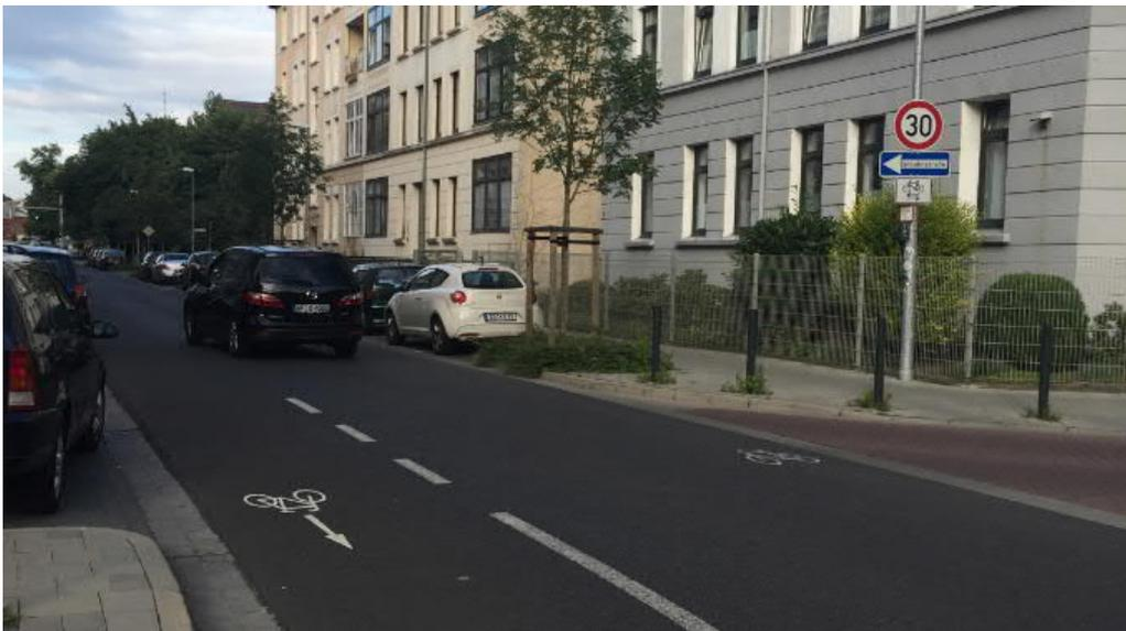
Abb. 21 Markierung von Fahrradpiktogrammen auf der Fahrbahn (Braunschweig)
