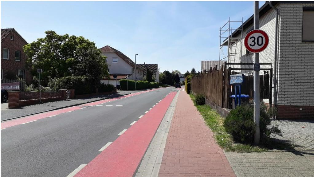
Abb. 20 Eingefärbte Schutzstreifen in Kombination mit Tempo 30 in Harenberg (Seelze)
