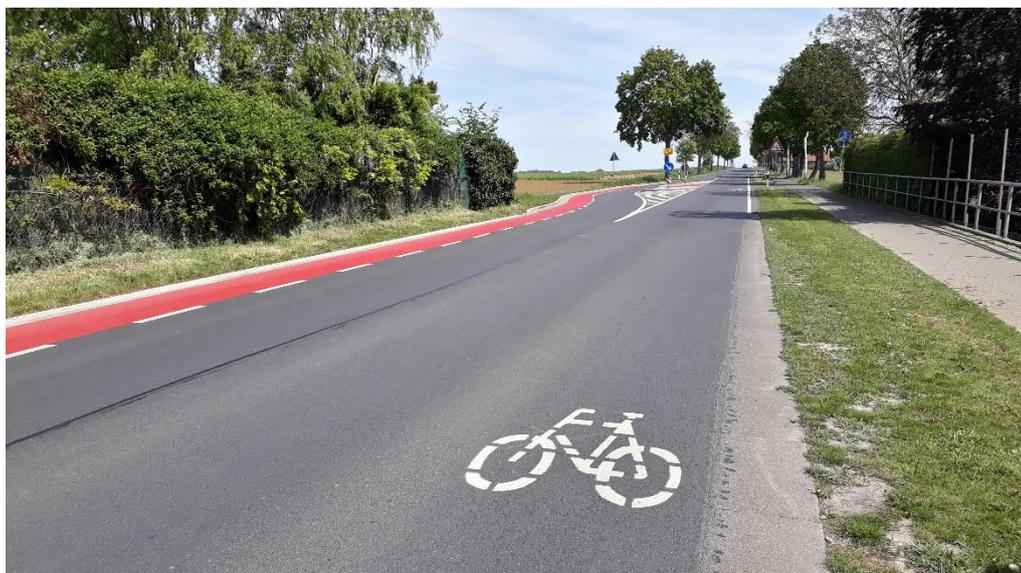
Abb. 24 Einseitige Markierung von Schutzstreifen und Markierung von Fahrradpiktogrammen auf der Fahrbahn (Seelze)
